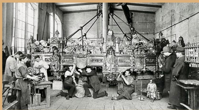
Der beschriebene Kronleuchter bei seiner Fertigung 1894 in der Halle der Firma Riedinger in Augsburg.
