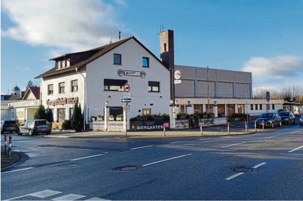
Rund 50 Jahre alt ist die Halle der TGS an der Grabenstraße. Wegen vieler Mängel ist die Nutzung durch die Sportler aktuell nur geduldet. Der Verein hofft deshalb auf eine neue, städtische Sporthalle, in der die TGS die Hauptnutzerin wäre.
