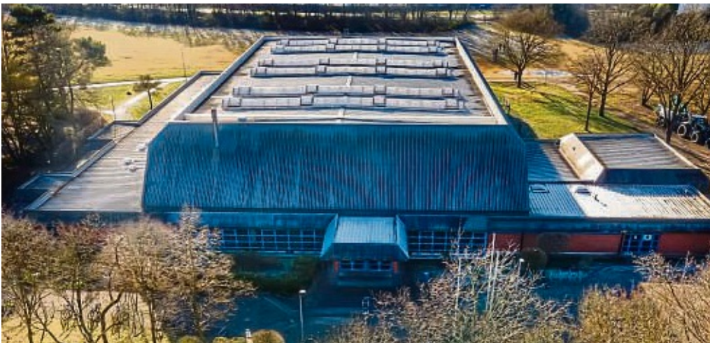
Die Kreuzburghalle im Hainburger Ortsteil Klein-Krotzenburg steht auf der Prioritätenliste bei den Investitionen der Gemeinde ganz oben. Sie soll technisch sowie energetisch saniert werden.
