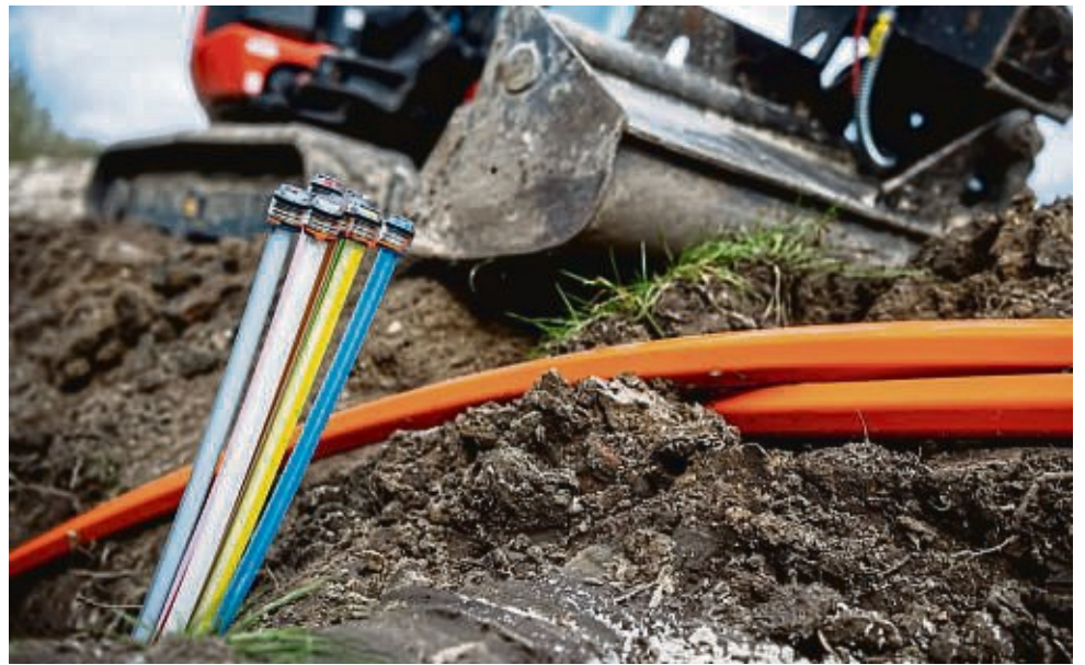
Bis im Seligenstädter Süden die Bagger für den Glasfaser-Ausbau anrollen, dauert es noch mindestens bis kommendes Jahr. SymbolFoto: Sina Schuldt/dpa
