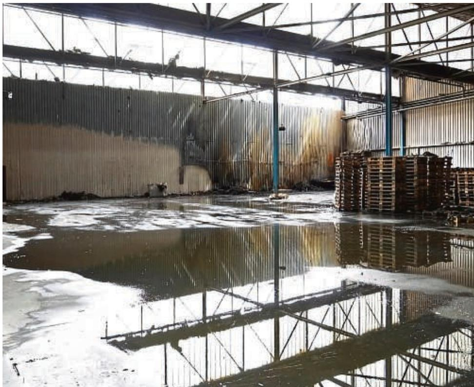
Ein technischer Defekt an der Wand zwischen den beiden Lagerhallen war offenbar der Grund für den Brand. Die Glasfront unter dem Dach erschwerte der Feuerwehr die Löscharbeiten im Inneren.
