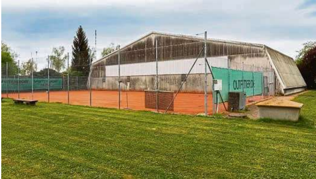
Der Außenplatz wandert nach innen: Wenn die TSG Mainflingen ihre Tennishalle erweitert, wird einer der sechs Plätze mit überdacht.
