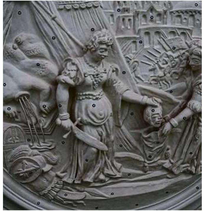
**Sanierung der Stuckdecke im Erkerzimmer:** Die Fläche wurde mit reflektierenden Klebepunkten bestückt. FOTOS: P
