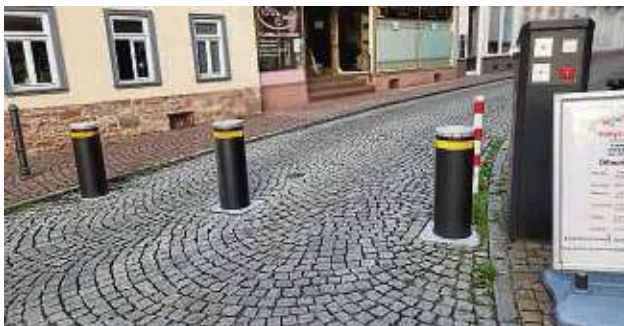
Seit November 2020 stehen diese Poller auf der Frankfurter Straße vor der Zufahrt zum Marktplatz.
