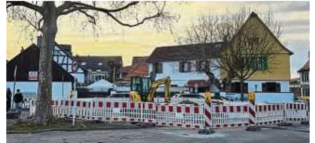
Baustelle am Obertor: An der Aschaffener, Ecke Zellhäuser Straße, entsteht die nächste Anlage für versenkbare Poller.
