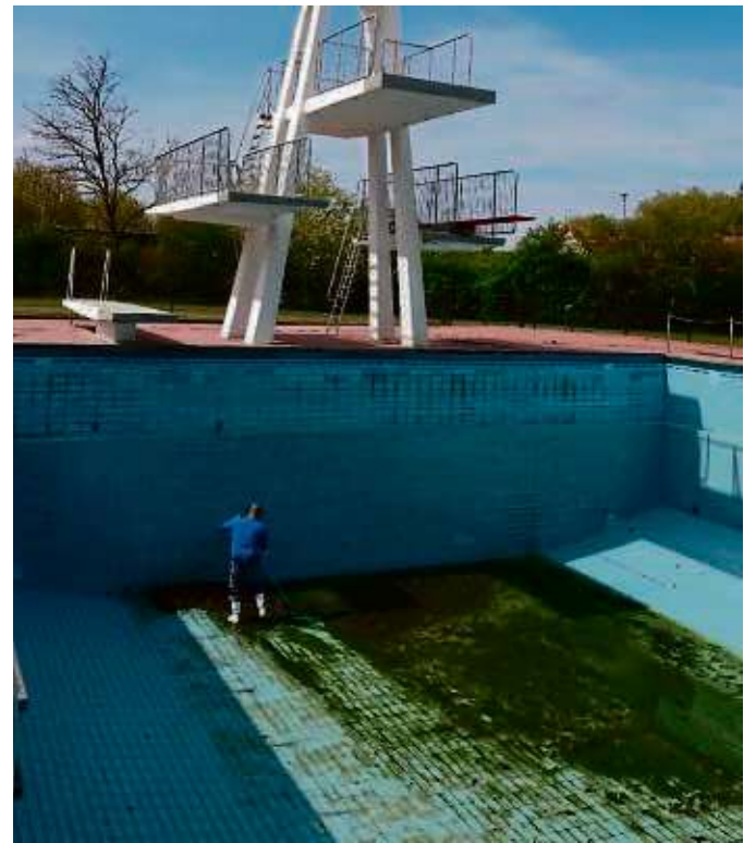
Nach dem Winter wurden die Becken im Seligenstädter Freibad gründlich gereinigt.
