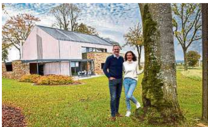
240 integrierte Solarpaneele im nachhaltigen Rathscheck Schiefer-System erzeugen auf dem Ferienanwesen in den Eifel-Ardennen bis zu 12 kW Strom – genug, um das Ensemble von Christianne und Philippe Heck im ehemaligen Geisterdorf Stefanshof nahezu unabhängig zu versorgen. Fotos: Rathscheck
