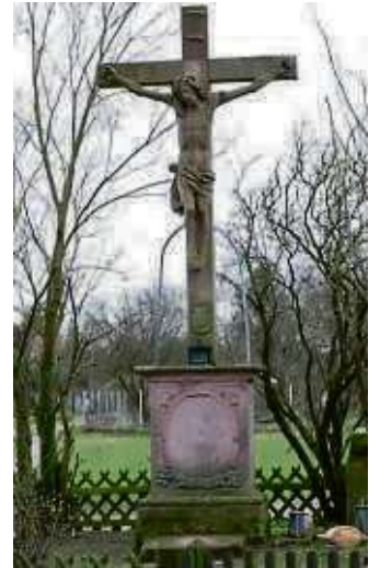
In schlechtem Zustand ist das Feldkreuz. FOTO: HOFMANN
