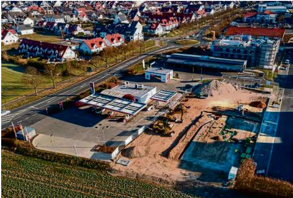
Die Bauarbeiten für das neue Schnellrestaurant im Gewerbegebiet Südlich der Dudenhöfer Straße haben begonnen. FOTO: HAMPE
