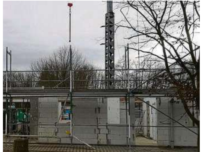
Auf Hochtouren laufen die Arbeiten am Eingangsgebäude zum Mainflinger Badesees.
