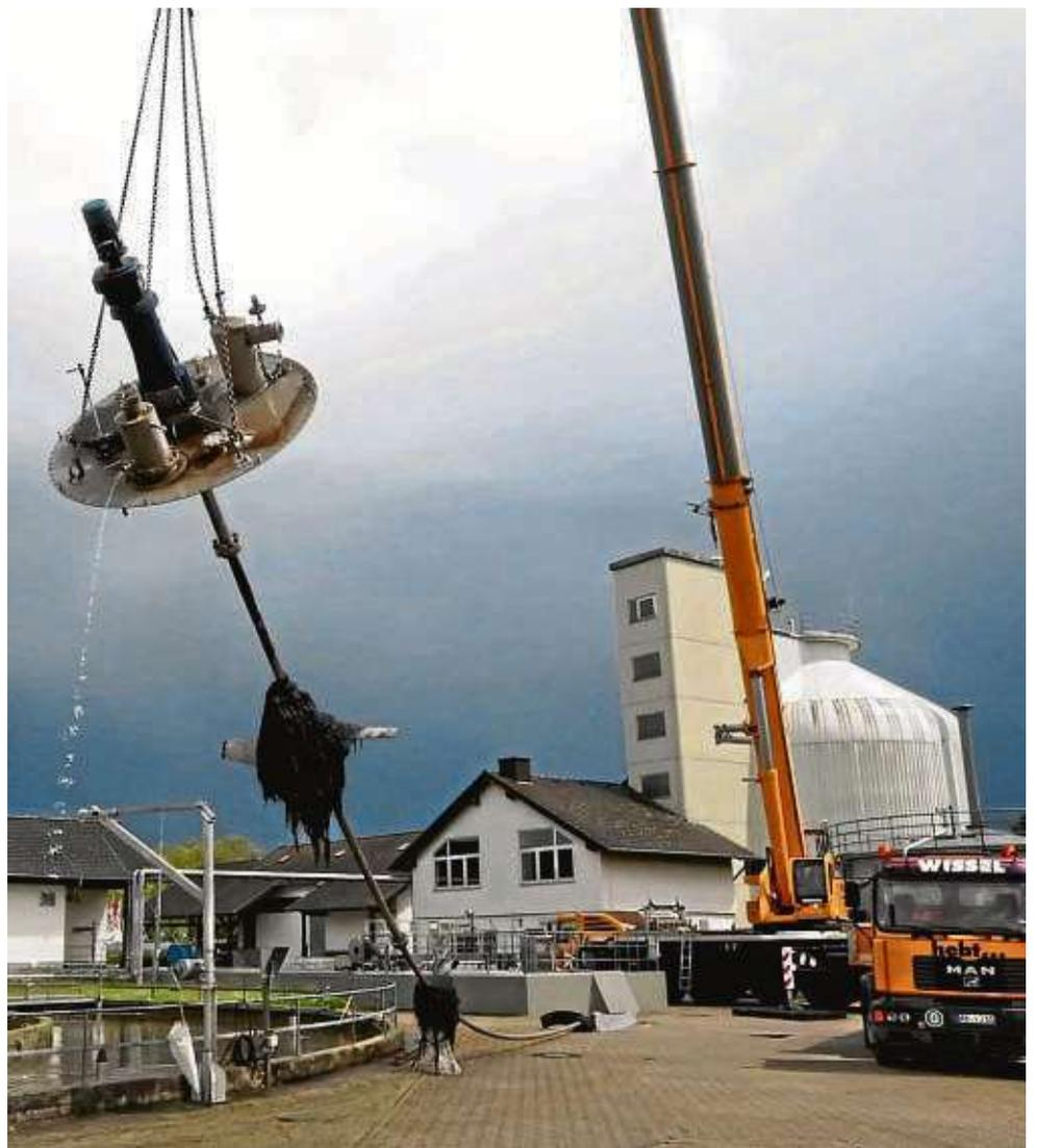
**Die Bergung des defekten Rührwerks** war nur mit dem Autokran möglich.
