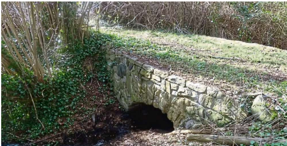
Die Grasbrücke hatte durch das Geleitswesen einst große Bedeutung.
