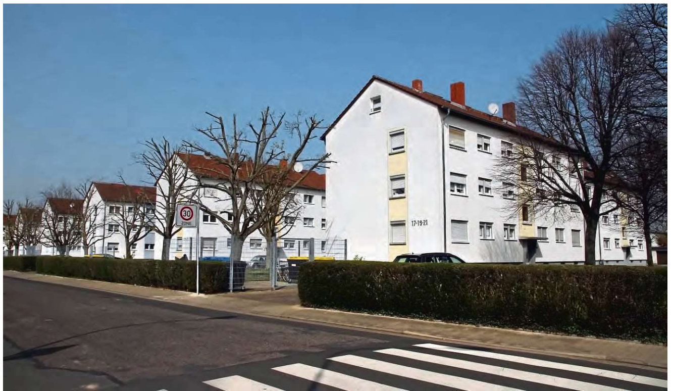
Städtische Gebäude an der Querstraße: Dach- und Fassadensanierung sind für insgesamt 190.000 Euro geplant.
