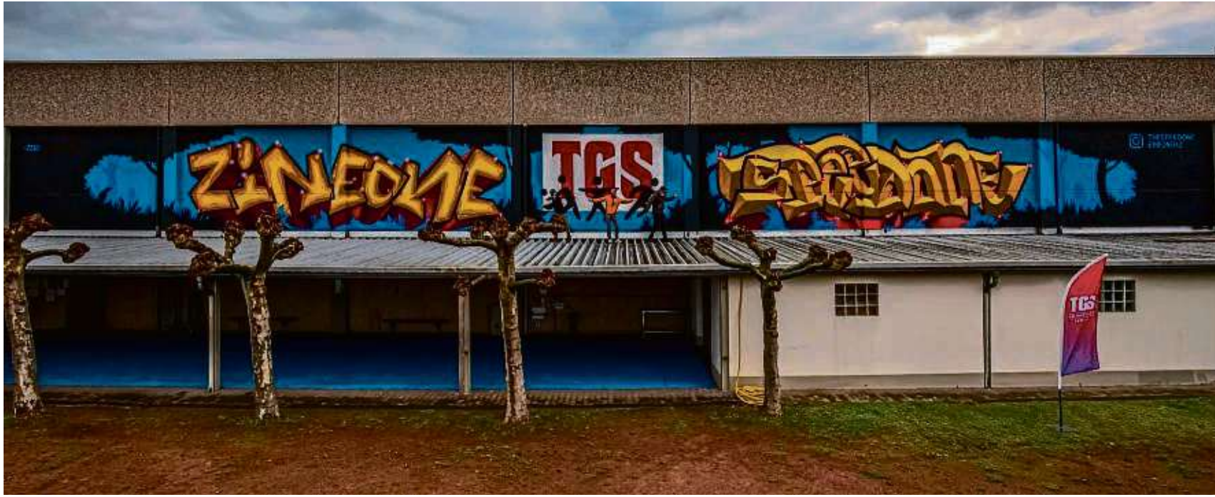
In trüben Zeiten gilt es bunt gegenzusteuern: Auf der dem Sportplatz zugewandten Seite der Halle der TGS Seligenstadt erstrahlt seit wenigen Wochen ein riesiges, farbenfrohes Graffiti. Der Verein hat zwei jungen Künstlern die Möglichkeit gegeben, einen Teil der Sporthalle zu verschönern. Die ehrenamtlich arbeitenden Künstler Daniel (Künstlername Speedone) und Thilo (Zineone) haben auf einer Fläche von nicht weniger als rund vier mal 50 Metern ihre Interpretation von Graffiti und Sport dargestellt. „Sport, Kunst und Kultur besitzen bei uns traditionell einen hohen Stellenwert,“ sagt hierzu Ralf Mutschke, der 2. Vorsitzende der TGS. „Ich freue mich sehr über das farbenfrohe, weithin sichtbare TGS-Emblem mit den beiden Künstlernamen.“ Das Engagement der beiden Künstler ist beachtlich: In zwölf Tagen Arbeit wurden nicht weniger als 200 Liter Fassadenfarbe und 80 Sprühdosen verbraucht. Das Bild zeigt Ralf Mutschke in der Mitte mit Thilo und Daniel auf dem Vordach. Foto: p
