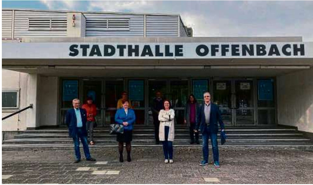
Baulich in schlechtem Zustand ist die Offenbacher Stadthalle, Technik und Ausstattung sind nicht mehr zeitgemäß und nun fehlen wegen Corona auch noch die Mitarbeiter. Die CDU machte sich vor Ort ein Bild von der aktuellen Lage. Foto: p
