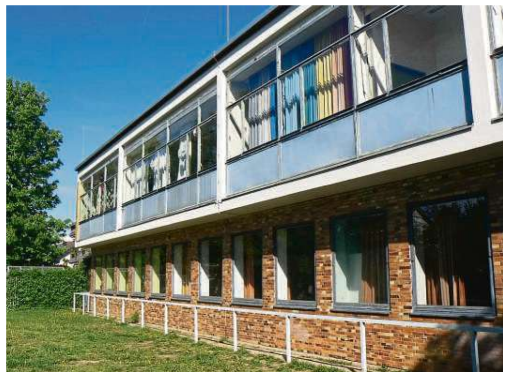
Fachklassentrakt (oben) und Aula werden saniert.
