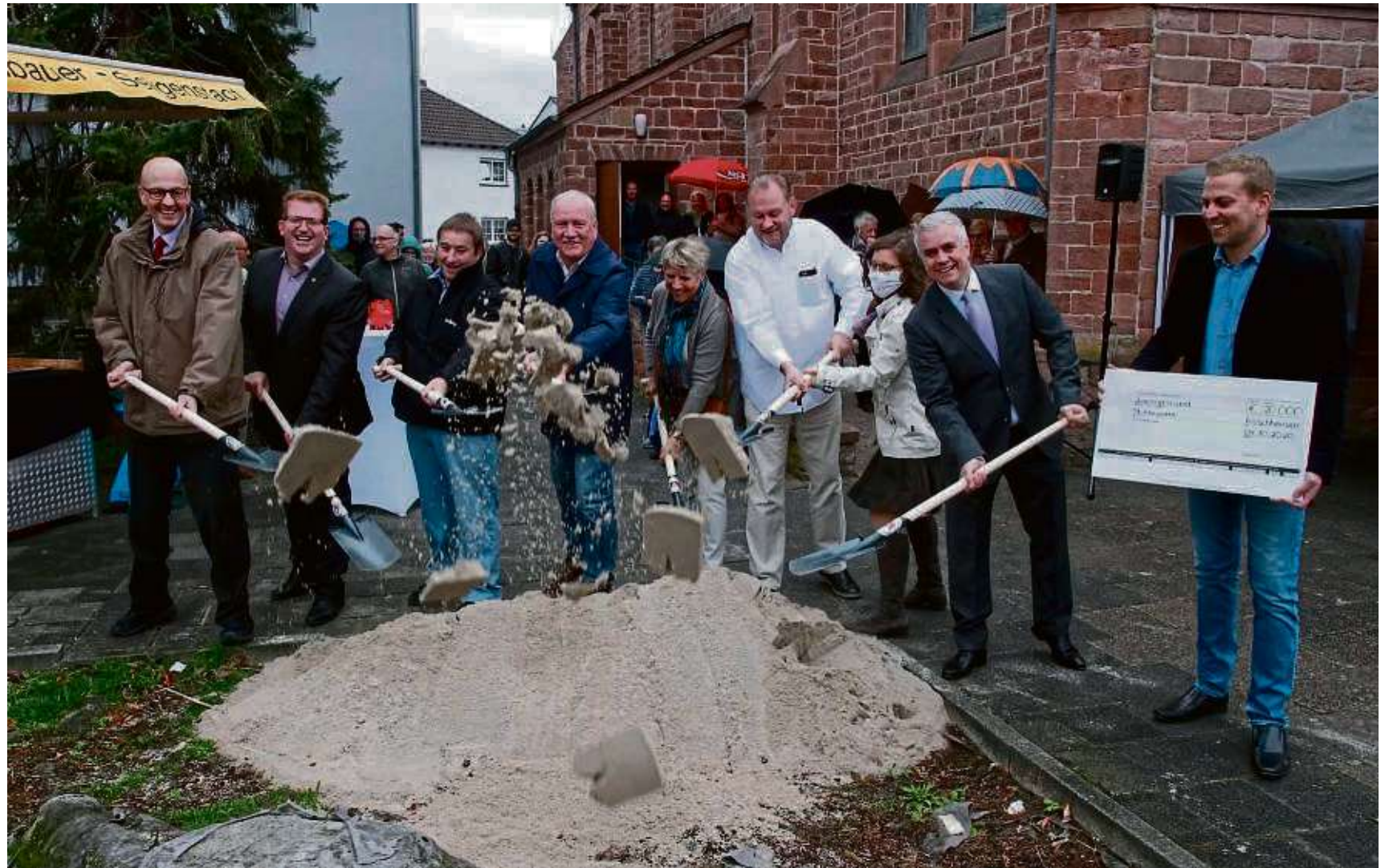
Erster Spatenstich zur Neugestaltung des Froschhäuser Kirchplatzes: Löcher und lose Steine hatten ein Sicherheitsrisiko dargestellt, der Verwaltungsrat der Pfarrgemeinde sah Handlungsbedarf. „Es muss etwas gemacht werden, und wenn etwas gemacht wird, dann auch schön.“ Dazu konstituierte sich ein Arbeitskreis Kirchplatz, der eine Planung ausarbeitete. Der Verwaltungsrat ging von Kosten in Höhe von etwa 200.000 Euro aus, eine Rückstellung in fünfstelliger Höhe hatte die Pfarrei bereits gebildet. Unmittelbar davor hatte die Stadt Seligenstadt die angrenzende Martingasse fertiggestellt, was knapp 150.000 Euro kostete. An den „wunderbaren Plänen für die Neugestaltung des Kirchplatzes“ beteiligt sich die Stadt mit einem Zuschuss von 20.000 Euro, berichtete Erster Stadtrat Michael Gerheim beim Starttermin.
