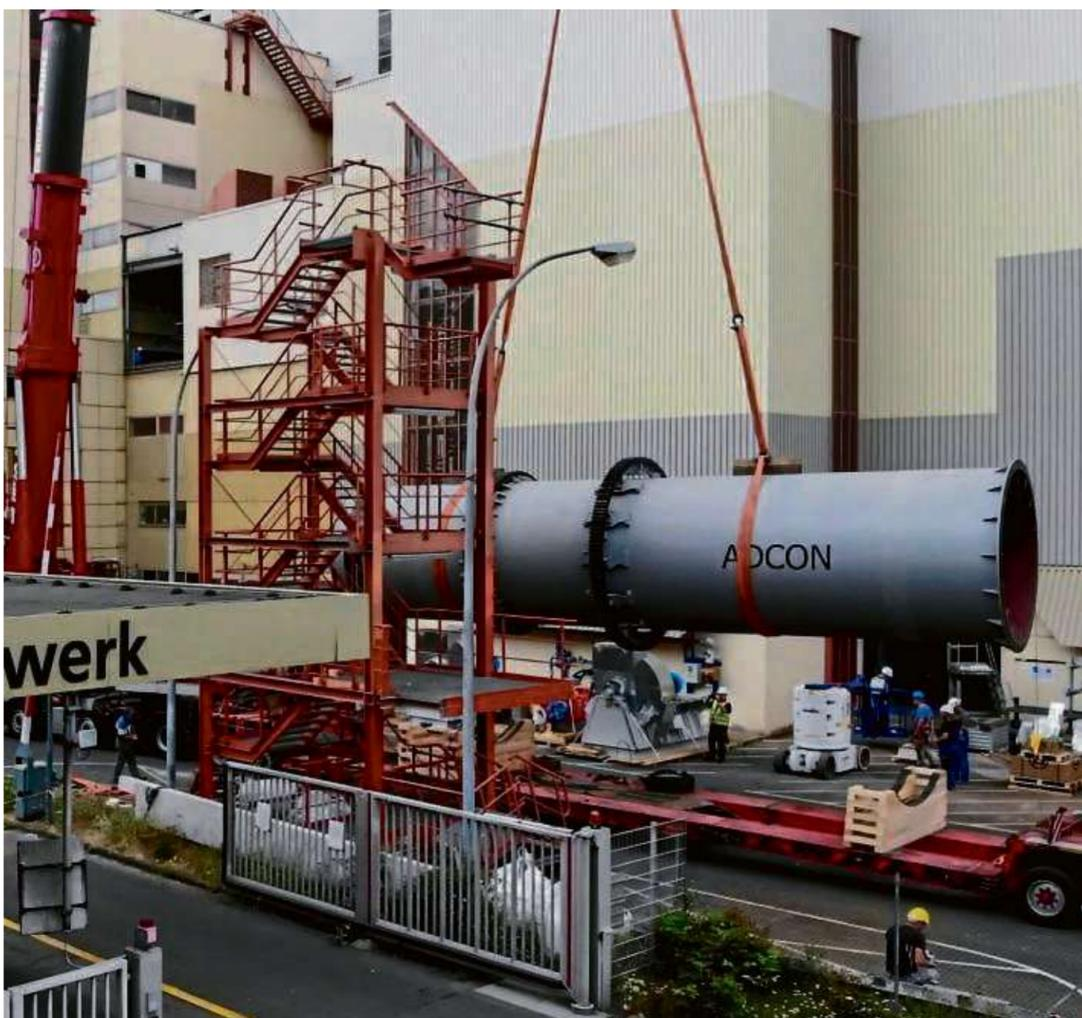
Das Foto zeigt die Verladung der Drehrohre, in denen später die Klärschlämme verbrannt werden, ins Kesselhaus.
