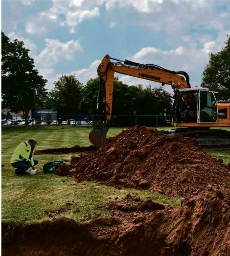
Mit Hilfe eines Baggers werden Proben für eine Bodenanalyse entnommen. Es ist der Beginn des Baus des neuen Hainburger Rathauses.
