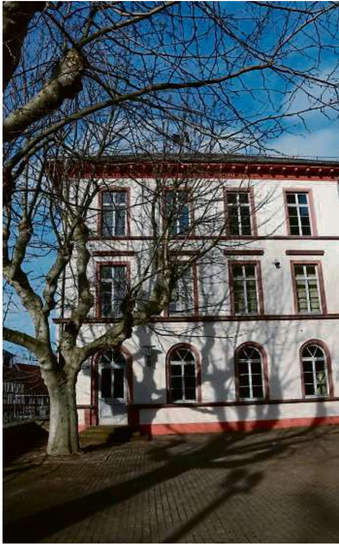
Weit vor dem Beginn der Bürgerbefragung bereits heftig in der Diskussion: Die Nutzung der ehemaligen Hans-Memling-Schule. F. beko
