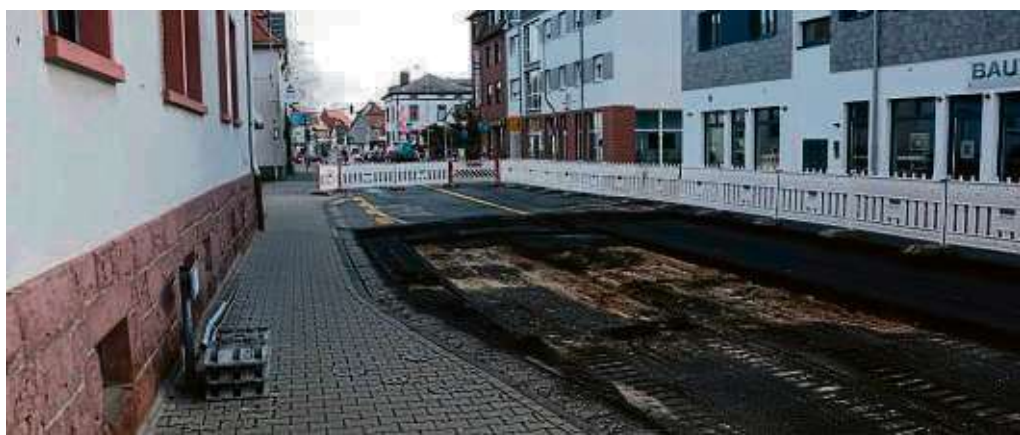
Etliche Arbeiten sind bereits im Gange an der Frankfurter Straße (hier ein Blick vom Feuerwehrhaus-Parkplatz in Richtung Innenstadt). Foto: beko
