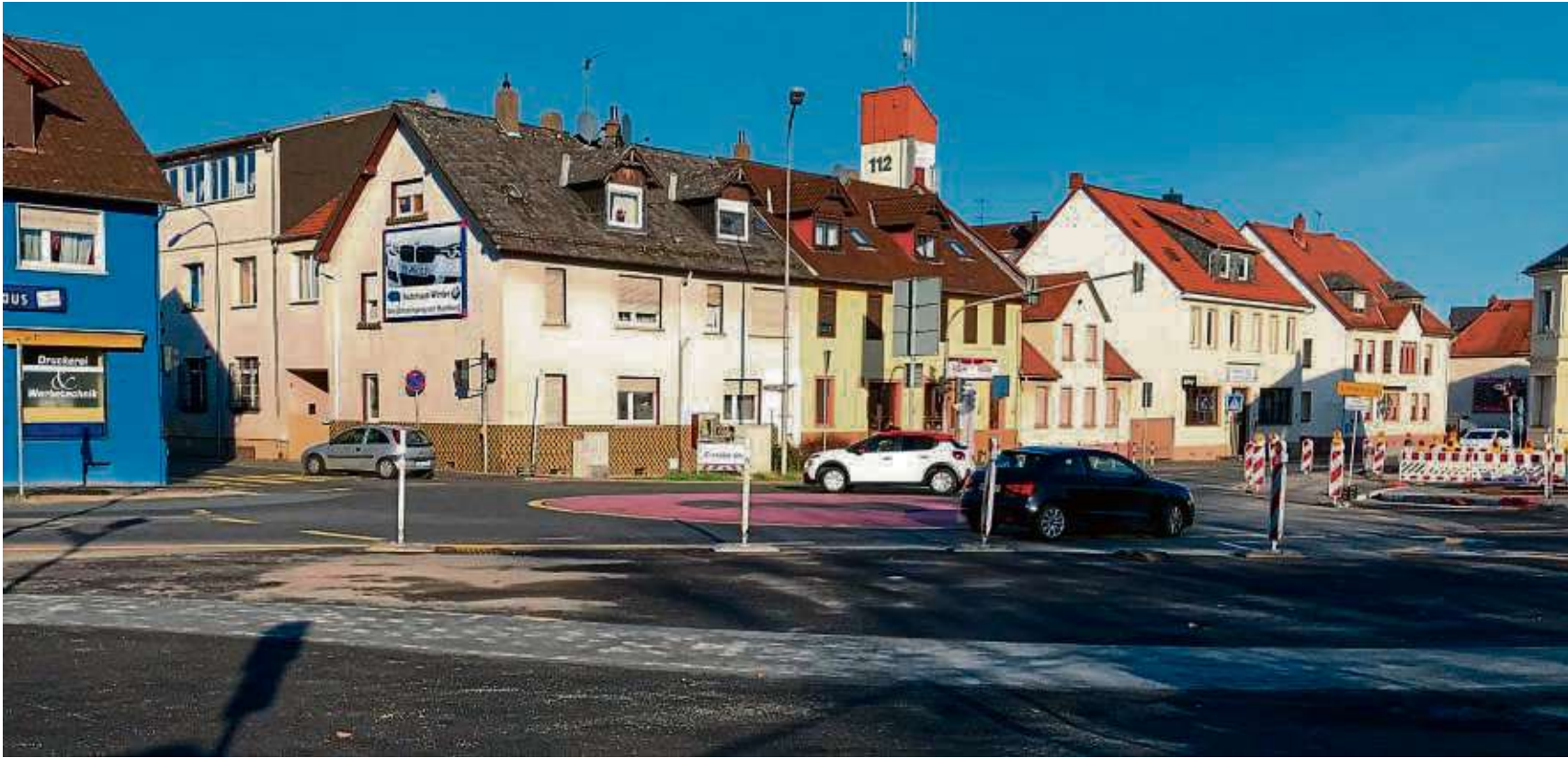
Kapellenplatz für Fastnacht frei: Der erste der drei Bauabschnitte ist fertig, der Baubeginn des zweiten, bautechnisch aufwendigsten schwierigsten ist für Aschermittwoch (26. Februar) vorgesehen. Danach werde eine Vollsperrung des Kreisverkehrs notwendig, kündigt Erster Stadtrat Michael Gerheim an. „Daher warten wir bis nach Fastnacht, damit der Umzug am Rosenmontag stattfinden kann.“
