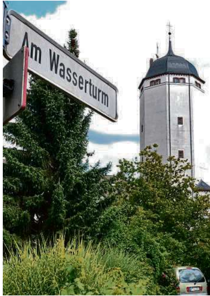
Zur Skyline Seligenstadts gehört der 1938 erbaute nahezu 52 Meter hohe Wasserturm, vor einigen Jahren zum Funkturm umfunktioniert.
