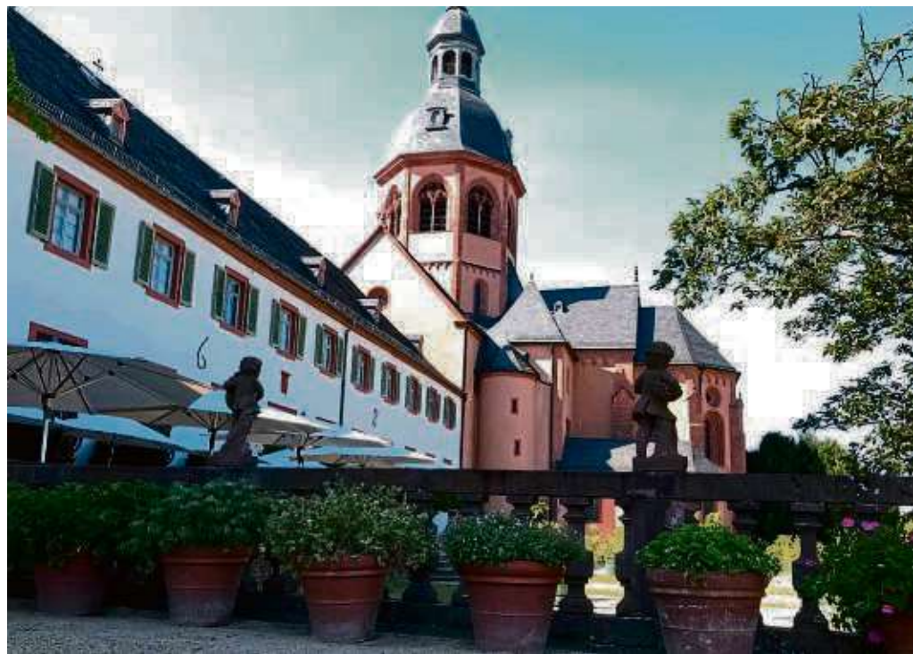
Die Schloßerverwaltung saniert auch die historische Balustrade in der früheren Benediktiner-Abtei, die die Café-Terrasse am Konventbau abschirmt.
