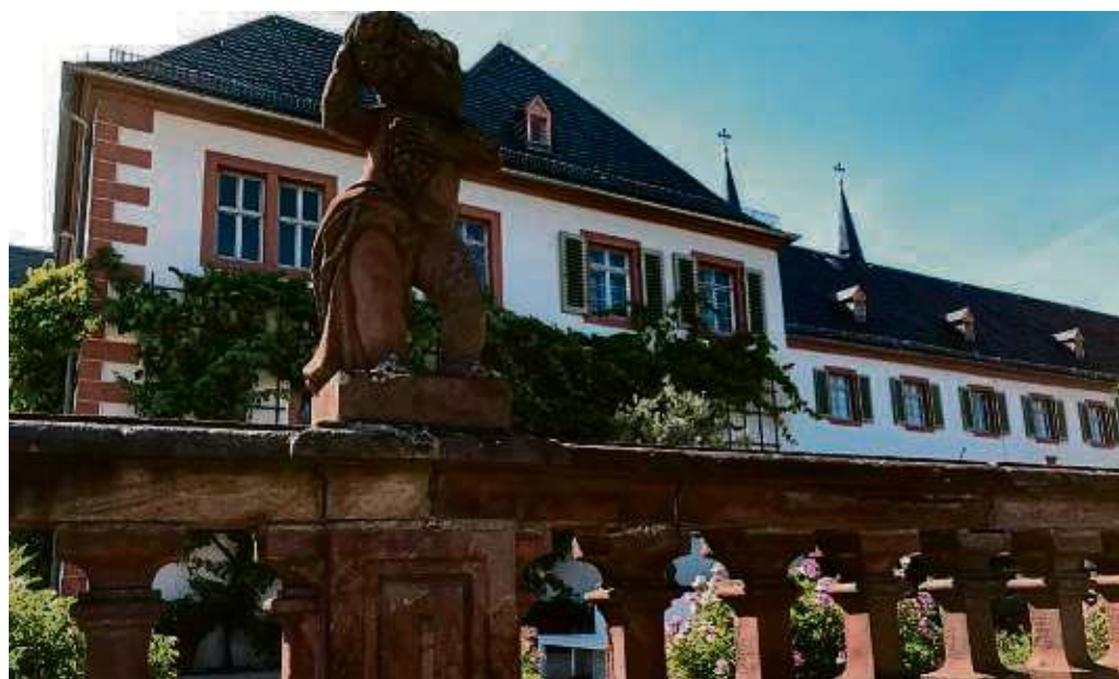
Bei etwa 134.000 Euro liegen die Kosten für die Sanierung der Balustrade am Konventbau. Die Kosten werden aus Mitteln der Bauunterhaltung finanziert.
