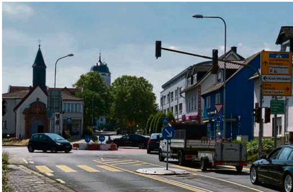
In 19 Tagen starten die Arbeiten an der „Hauptschlagader und einem der neuralgischsten Punkte im örtlichen Verkehrsnetz“ Seligenstadts, am Kapellenplatz.
