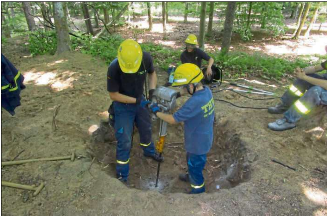
Ein Loch für die Wasserzufuhr bohrt die THW-Jugend in den Bunker, um die Luftfeuchtigkeit im Inneren zu erhöhen und den Fledermäusen optimale Bedingungen zum Überwintern zu bieten.
