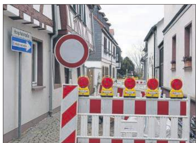
Die Verantwortlichen der Stadtwerke haben's geschafft: Gerbergasse frei, gesperrt ist nur noch die Hospitalgasse.
