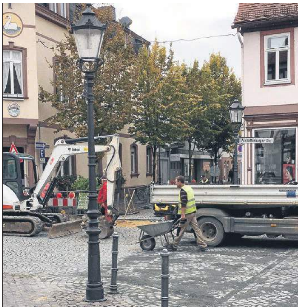
Allemaal zügig voran gehen die Bauarbeiten an der Ecke Aschaffener Straße / Palatiumstraße, die seit gestern wieder zu befahren ist. In einer Spezial-Bildergalerie hält die Redaktion die einzelnen Schritte fest. Derzeit wird der Fußgängerüberweg am Anfang der Bahnhofstraße erneuert. Mehr in der großen Bildergalerie auf www.stadtpost.de
