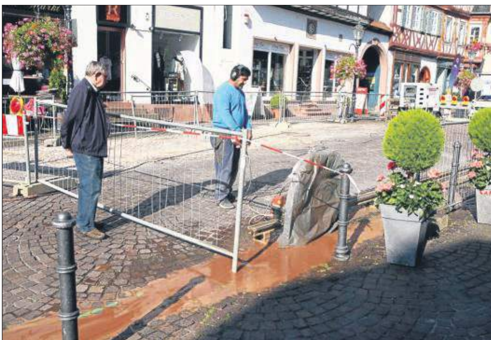
Mit Fugenschneidern lösen die Bauarbeiter das Natursteinpflaster. 40 Zentimeter tief geht es in die Decke, einschließlich Mörtelbett und Unterbeton.
