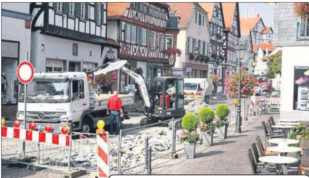
Der Natursteinbelag mit Mörtelbett und Unterbeton wird abgefahren, die Marktplatzdurchfahrt ist derzeit noch gesperrt.
