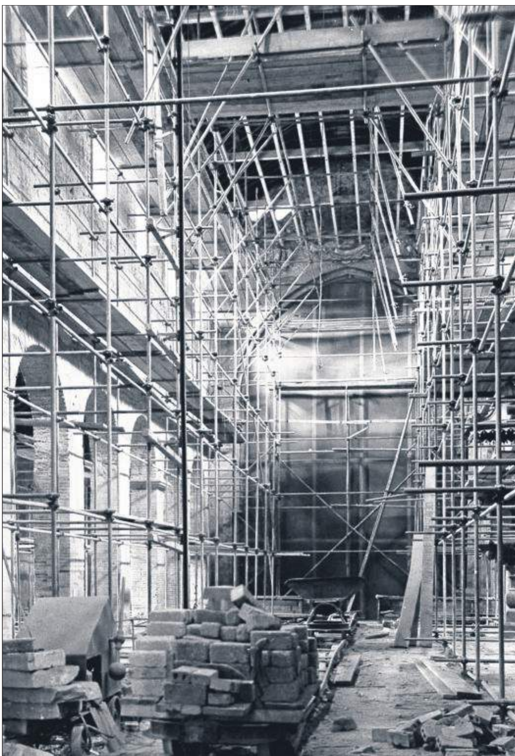
Aus dem Nachlass von Dr. Otto Müller stammen Fotos von den Renovierungsarbeiten in der Einhardbasilika ab dem Jahr 1953. Thomas Laube stellte das Foto zur Verfügung. Foto: Müller/p
