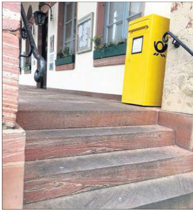
Bisher muss die Treppe überwunden werden, um an den Postbriefkasten zu gelangen. Das soll sich ändern. Foto: jacky
