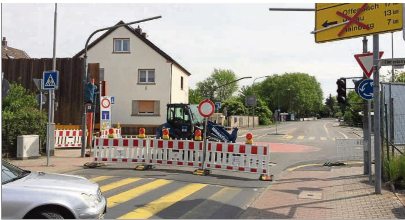
Komplett gesperrt ist seit gestern früh die Durchfahrt an der Würzburger Straße im Bereich Einhardstraße, worauf schon außerhalb der Stadt eindeutig hingewiesen wird.
