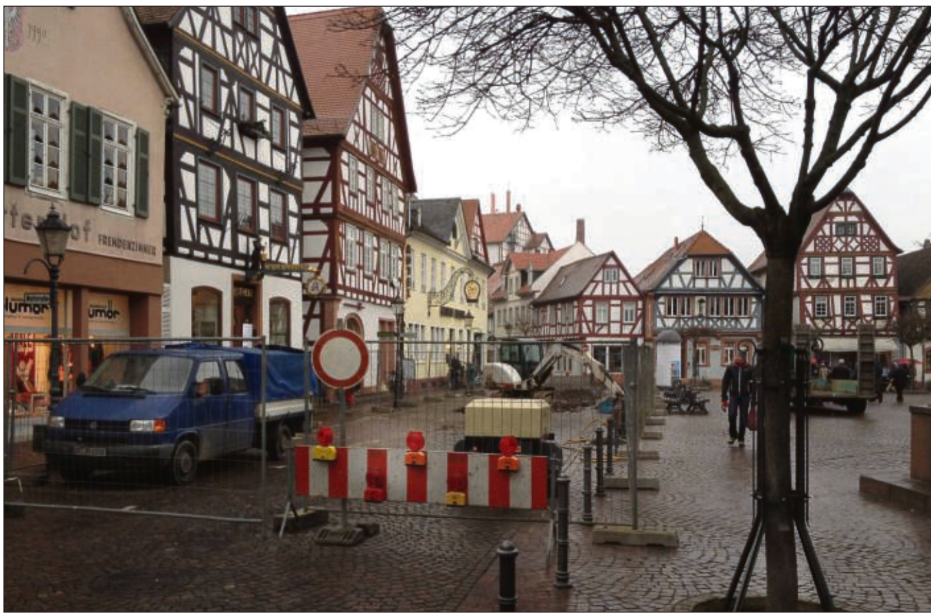
Ab sofort werden im Straßbereich des Marktplatzes die bereits vor Jahren begonnenen Instandsetzungsarbeiten im Fahrbahnbereich des Marktplatzes mit der vierten Teilflächensanierung fortgesetzt. Die Bauzeit beträgt etwa vier Wochen, die Kosten belaufen sich auf circa 50.000 Euro. Nach Angaben aus dem städtischen Tiefbauamt schließt dieser Abschnitt die Lücke zwischen den Anbauabschnitten vor dem Einhardhaus und dem Teil vor der Gaststätte „Riesen“. Am Montag wurde die Fahrbahn zwischen der Wolfstraße und der Gaststätte „Riesen“, um Platz für die Sanierungsarbeiten zu schaffen. Die Andienung aller Geschäfte sowie die Erreichbarkeit für Kunden, auch der Stadt Apotheke, sei jederzeit gewährleistet. Der Anliegerverkehr kann auch weiterhin über die Steinheimer Straße abfließen. Foto: beko
