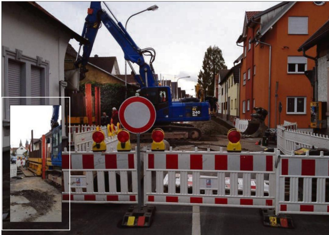
In die nächste Phase gehen derzeit die Arbeiten an der Großbaustelle in Seligenstadts Zentrum. Mit dem Auffräsen der Asphaltdecke und dem Einrichten der notwendigen Grundwasserhaltung zur Absenkung des Grundwasserspiegels haben Kanalbauarbeiten im Kreuzungsbereich Einhard- und Jakobstraße (unser Foto) begonnen. Im Kreuzungsbereich tauschen Arbeiter 20 Meter Kanalleitung mit einem Durchmesser von 80 Zentimeter bis 1,20 Meter aus. Die Arbeiten sollen bis Weihnachten abgeschlossen sein.
