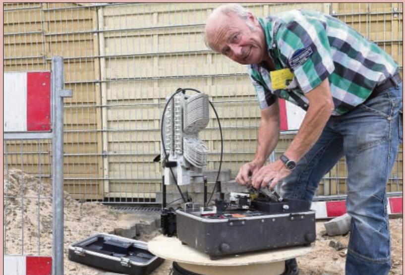
Beim Verlegen und Zusammenfügen der Glasfaserkabel bedient sich Wolfgang Schnabel eines Spleißgeräts modernster Bauart
