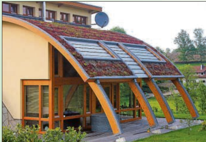
Eine Dachbegrünung bietet zahlreiche Vorteile und wird daher auch von vielen Kommunen bezuschusst. Foto: BHW Bausparkasse
