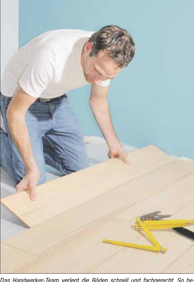
Das Handwerker-Team verlegt die Böden schnell und fachgerecht. So bekommen Kunden ein Rundum-Sorglos-Paket, das keine Wünsche offen lässt!
