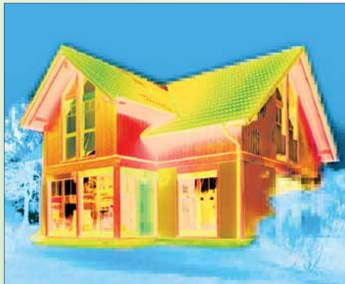
Ips/Bo. Das Wärmebild-Foto offenbart die Schwachstellen der Hausfassade. Foto: Schwäbisch Hall
