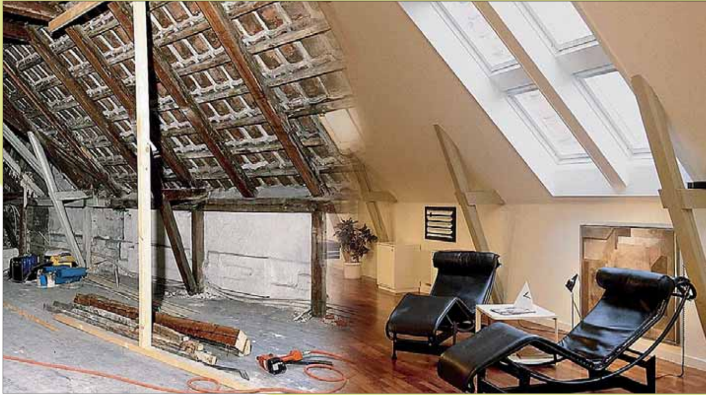
Ips/Bo. Ein wärmedämmtes und ausgebautes Dach schafft neuen Wohnraum.
