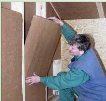
Ips/Bo. Holzfaserdämmplatten eignen sich auch für Zwischenwände. Foto: vhd
