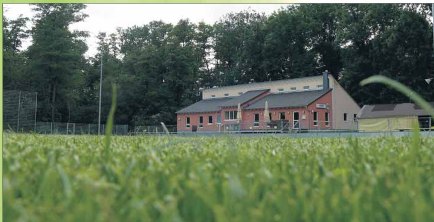
Rechtzeitig zum Vereinsjubiläum der TuS konnte der Umbau des Sportplatzes erfolgen. Dieser Tage ist der sattgrüne Rollrasen verlegt worden, kann allerdings erst nach einer mehrwöchigen Anwuchsphase genutzt werden.
