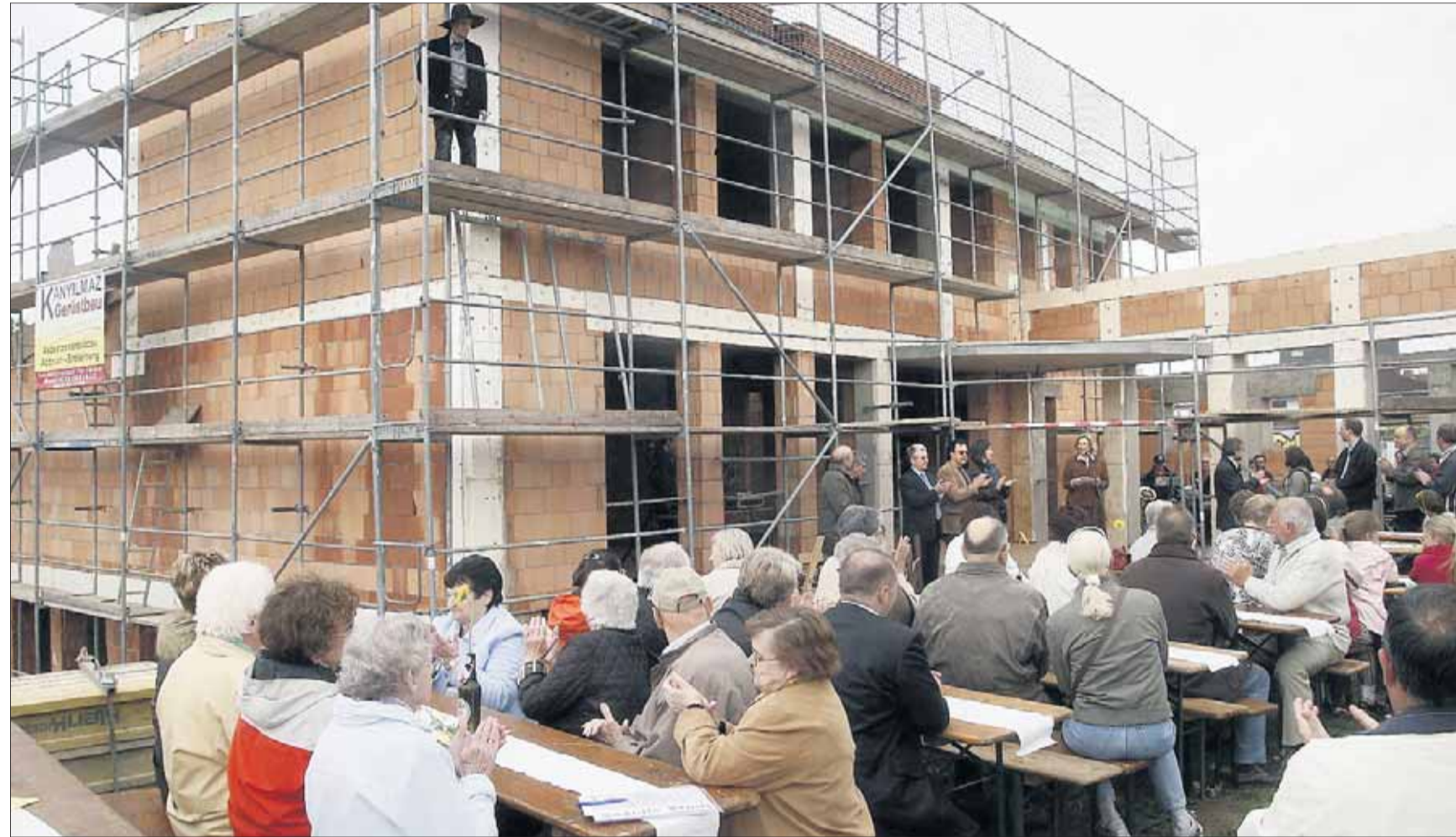
Dem Richtspruch des Zimmermanns John Witt lauschten zahlreiche Gäste, welche den Baufortschritt des neuen Nachbarschaftshauses bestaunten. Bereits bis zum Jahresende soll das neue Kommunikationszentrum für den nördlichen Stadtteil bezugsfertig sein. Fotos: Hampel
