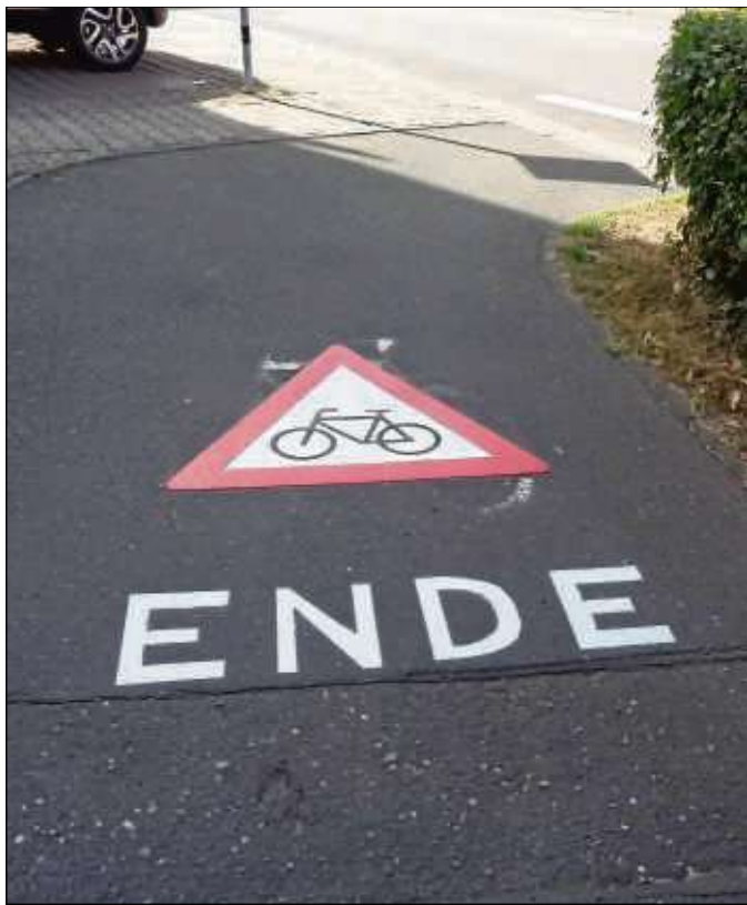
Die Mitarbeiter des Bauhofs haben in der vergangenen Woche verblasste Bodenmarkierungen, die als Hinweis für Radfahrer dienen, erneuert. Diese Maßnahme war notwendig, da der gemeinsame Rad- und Fußweg wenige Meter nach der Markierung an der Babenhäuser Straße endet. Um rechtzeitig auf das Ende hinzuweisen, wurden ein Achtungssymbol mit einem Fahrrad mittig und das Wort „Ende“ gut sichtbar aufgebracht. Foto: p
