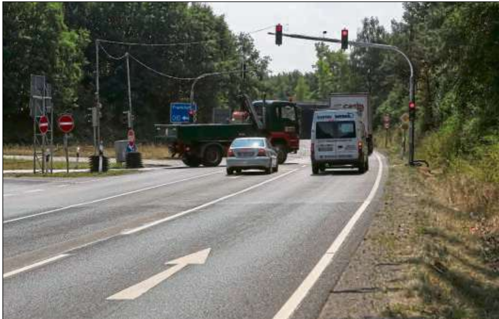
Im Bereich der Auffahrt von der L 2310 auf die A 45 (Anschlussstelle Mainhausen) ist seit einigen Tagen eine Ampel aufgebaut. Foto: zmb
