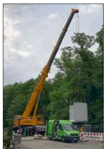
Der Kran setzt die Zisternen in die Baugrube.
