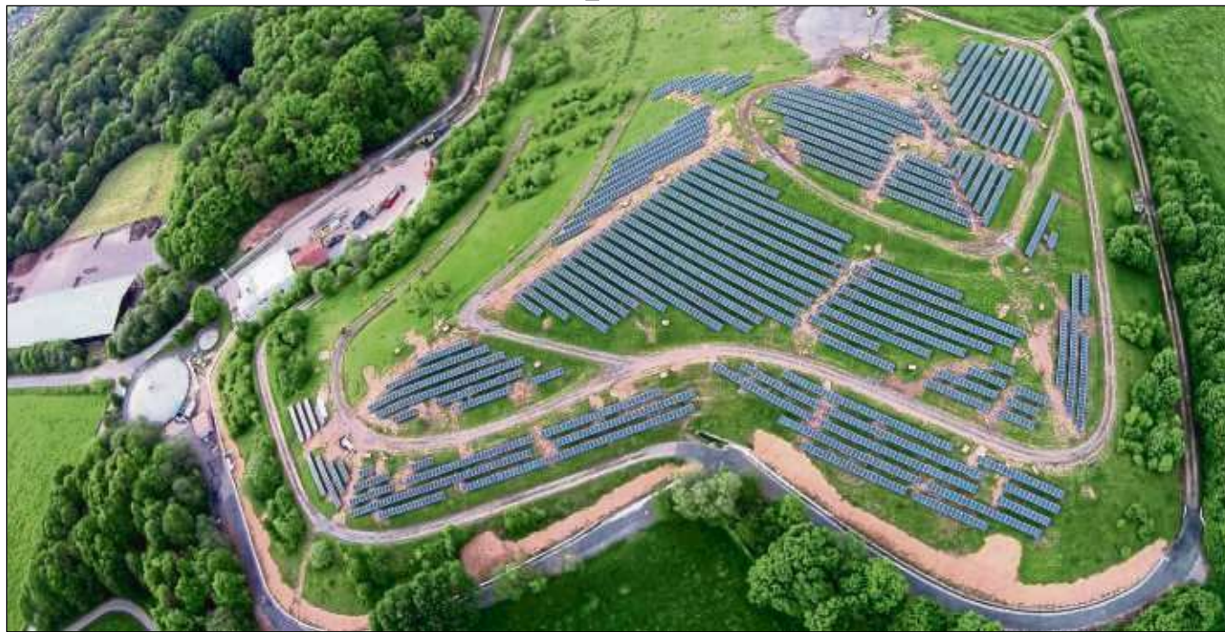
Die 11.000 Quadratmeter große Freiflächen-Anlage der EVO auf der Deponie bei Schlüchtern-Hohenzell.
