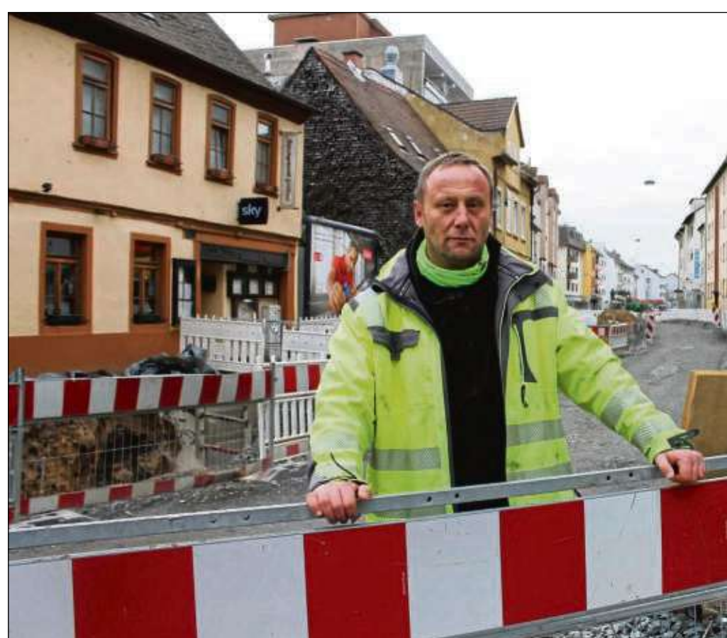
„Früher gab es das nicht“, sagt Oberpolier Guido Luhn auf der Baustelle Offenbacher Landstraße in Oberrad. Regelmäßig werden er und seine Kollegen von auswärtigen Autofahrern beleidigt. Foto: kb
