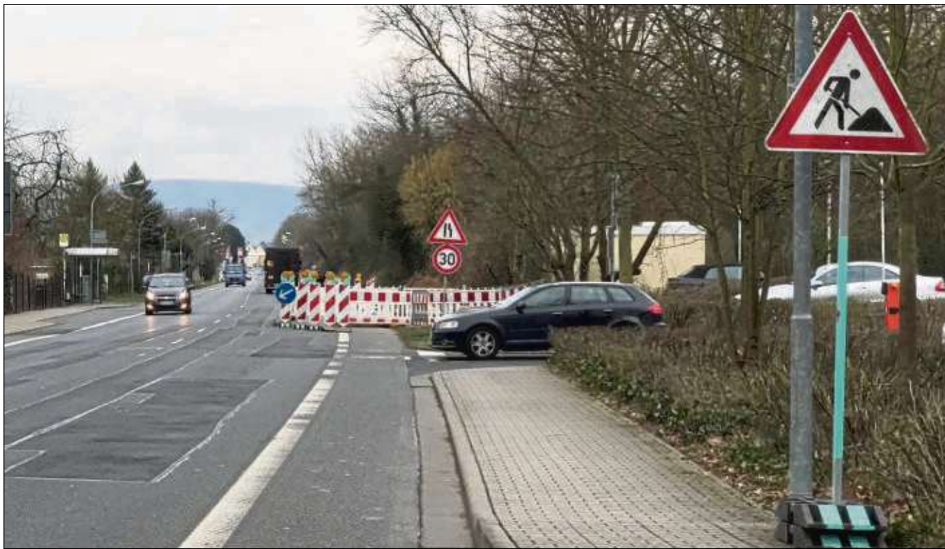
Noch ist einigermaßen ein Durchkommen möglich, die Sanierung der Wasserleitungen zwischen Seligenstadt und Klein-Welzheim an der K185 ist nur das Vorspiel. Ab April geht hier acht Monate nichts mehr. Die Lebensader wird Großbaustelle. Foto: beko
