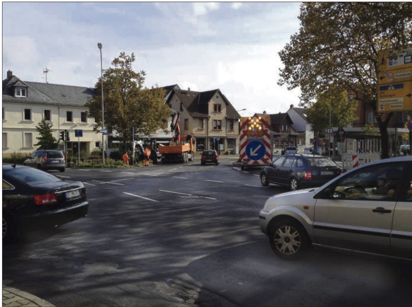
So langsam geht es los in der Stadt. Die ersten Arbeiten zur „Großbaustelle“ haben begonnen, am Kapellenplatz (unser Foto) ebenso wie an der Einhardstraße, an der Jakobstraße und an manch anderen Ecken der Einhardstadt. Wohl durchdacht sind viele Arbeiten, auch dass bestehende Markierungen nicht unbedingt weggefräst werden, sondern im Blickfeld der Autofahrer bleiben. Mehr in den nächsten Ausgaben des SHB. Text/Fotos: beko
