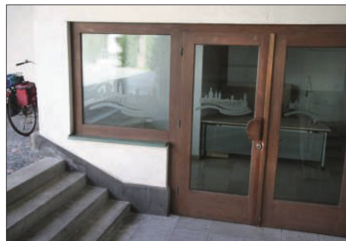
Hier soll die alte Rathausuhr nun ihren neuen Platz finden im Eingangsbereich zum Rathaus-Innenhof.
